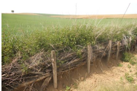
Figure 1. Exemple de fascine (Cliché : Flinois, G.)
